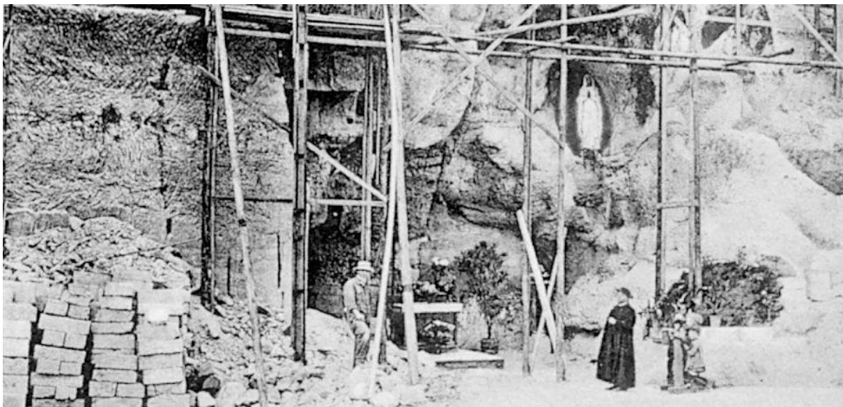
Bouw van de grot met mergelblokken (links) onder toezien oog van de pastoor (rechts). Collectie M. Stevensfonds.
